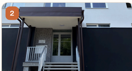
2 Drzwi wejściowe budynku
