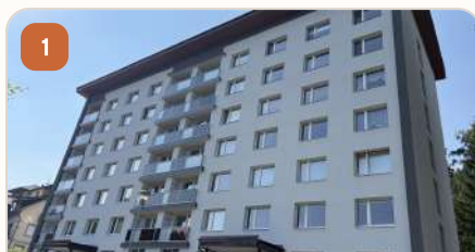
1 Wejście do budynku nr 257
